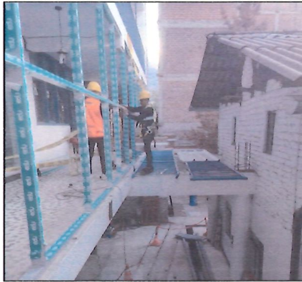
Imagen N° 11: Instalación de ventanas en pasadizos
